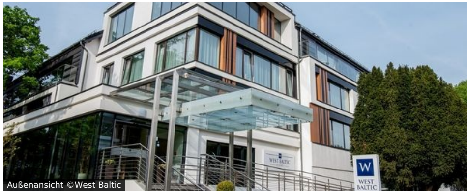
Außenansicht ©West Baltic
