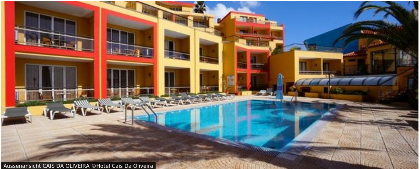
Aussenansicht CAIS DA OLIVEIRA ©Hotel Cais Da Oliveira
