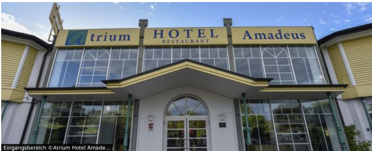
Eingangsbereich ©Atrium Hotel Amade...
